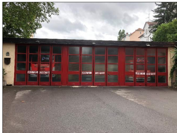
Abb.: Feuerwehrhaus Münster (Quelle Bildmaterial: LülF+)
