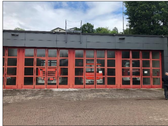
Abb.: Feuerwehrhaus Botnang (Quelle Bildmaterial: Lül+)
