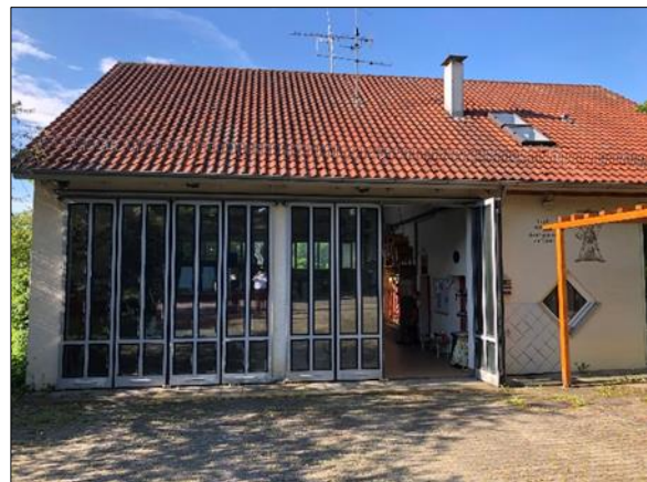
Abb.: Feuerwehrhaus Bünsau (Quelle Bildmaterial: Lül+)
