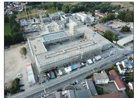
Abb.: Bauzustand Ende 2020 der Feuer- und Rettungswache 5 (Quelle Bildmaterial: Fw Stuttgart)
