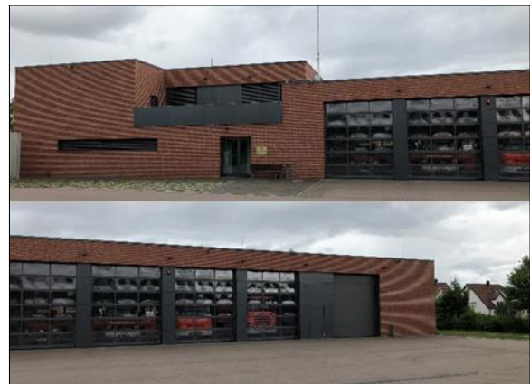
Abb.: Feuerwehrhaus Stammheim (Quelle Bildmaterial: Lül+)
