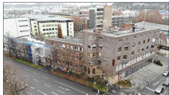
Abb.: Feuerwache 4 (Quelle Bildmaterial: Fw Stuttgart)
