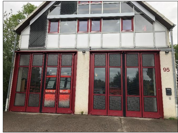
Abb.: Feuerwehrhaus Sommerrain (Quelle Bildmaterial: Lül+)
