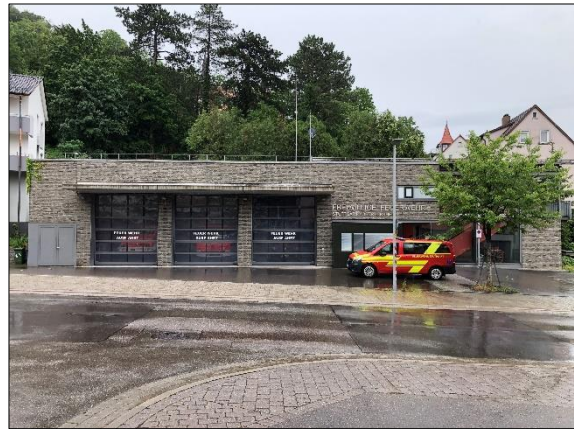
Abb.: Feuerwehrhaus Obertürkheim (Quelle Bildmaterial: Lül+)
